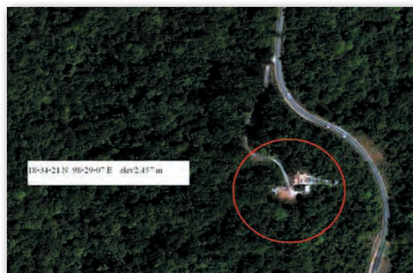
ภาพถ่ายดาวเทียมแสดงสถานที่ก่อสร้าง หอดูดาวแห่งชาติเฉลิมพระเกียรติ
