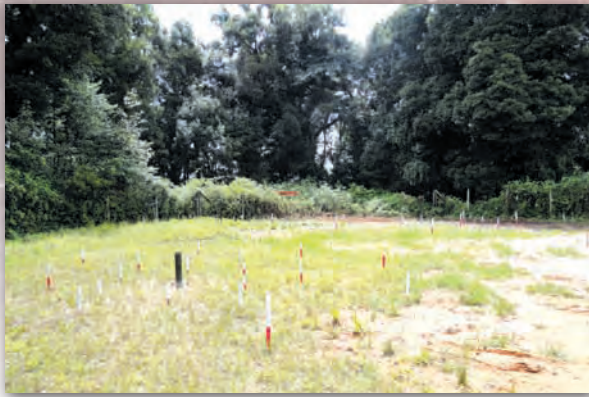
การวางตำแหน่งเสาเข็มของอาคารหอดูดาว และอาคารควบคุม
