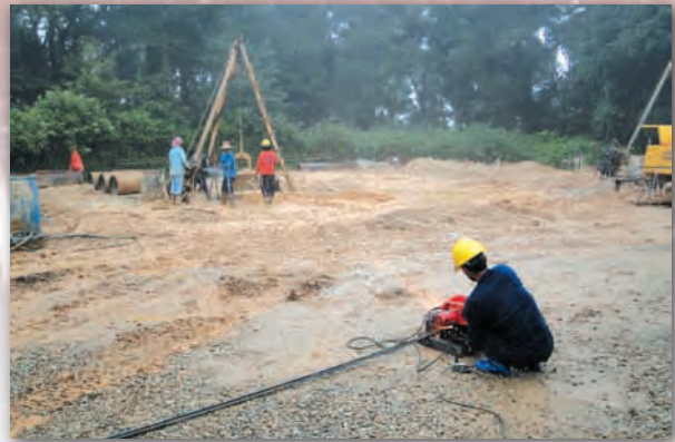
การเจาะเสาเข็มของอาคารหอดูดาว
