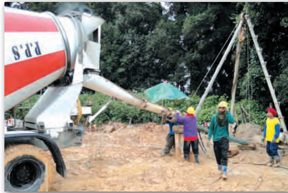
การเทคอนกรีตโครงสร้างเสาเข็มเจาะ
