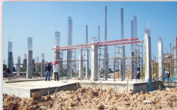
ภาพแสดงการก่อสร้างอาคารโถงทางเข้าทางเข้า Entrance Hall
