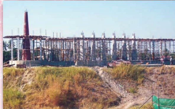
ภาพแสดงการก่อสร้างอาคารหอดูดาว Observatory Building
