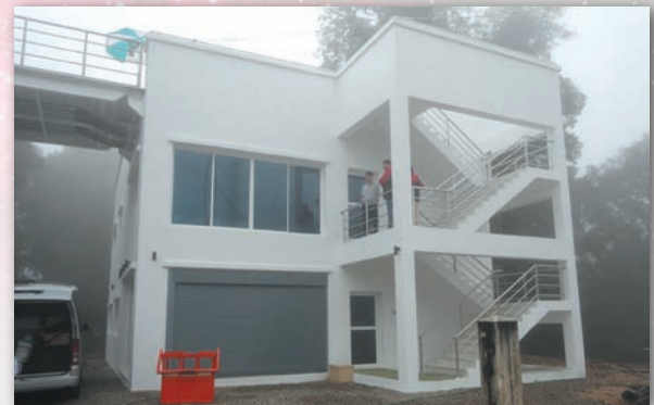
ภาพแสดงการก่อสร้างอาคารควบคุม Control Building
