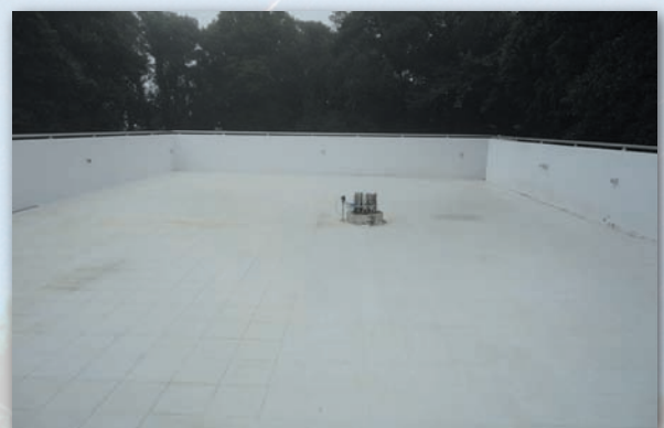
ภาพแสดงการก่อสร้างชั้นดาดฟ้าของอาคารควบคุม Rooftop of the Control Building
