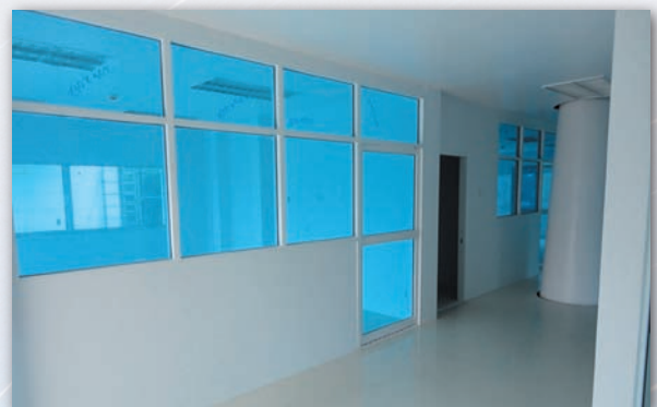
ภาพแสดงการก่อสร้างชั้นที่ 2 ของอาคารควบคุม The second floor of the Control Building
