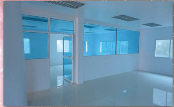
ภาพแสดงการก่อสร้างห้องควบคุม Control room
