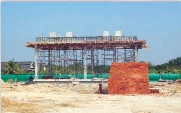
ภาพแสดงการก่อสร้างอาคารไฟฟ้า Power Plant Building
