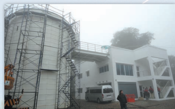
ภาพแสดงการก่อสร้างอาคารควบคุม และอาคารหอดูดาว Observatory Building
