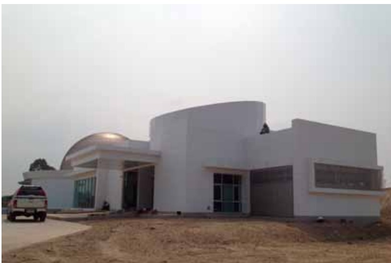
ภาพแสดงการก่อสร้างอาคารฉายดาว หอดูดาวเฉลิมพระเกียรติฯ ฉะเชิงเทรา
