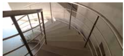
ภาพแสดงการก่อสร้างอาคารหอดูดาว หอดูดาวเฉลิมพระเกียรติฯ ฉะเชิงเทรา
