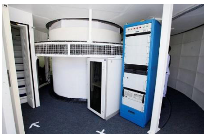
ชั้นที่ 1 ติดตั้งเครื่องคอมพิวเตอร์ เซิร์ฟเวอร์ สำหรับควบคุมกล้องโทรทรรศน์และโดม
