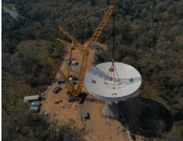
ขณะยกและติดตั้งงานรับสัญญาณขนาด 250 ตัน
