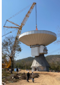
ขณะยกและติดตั้งงานรับสัญญาณขนาด 250 ตัน
