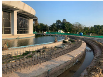
วางระบบน้ำอาคารห้องฟ้าจำลอง
