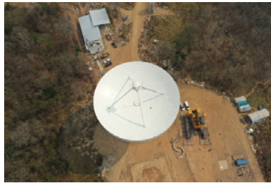
ขณะยกและติดตั้งงานรับสัญญาณขนาด 250 ตัน
