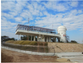
ทางลาดผู้พิการ อาคารหอดูดาว
