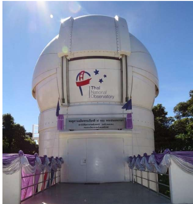
ภาพประกอบที่ 2.10 ทางเข้าอาคารหอดูดาวบริเวณชั้นดาดฟ้าอาคารควบคุม ที่มา: http://www.narit.or.th/index.php/telescope/tno . สืบค้นเมื่อ 6 ธันวาคม 2563
