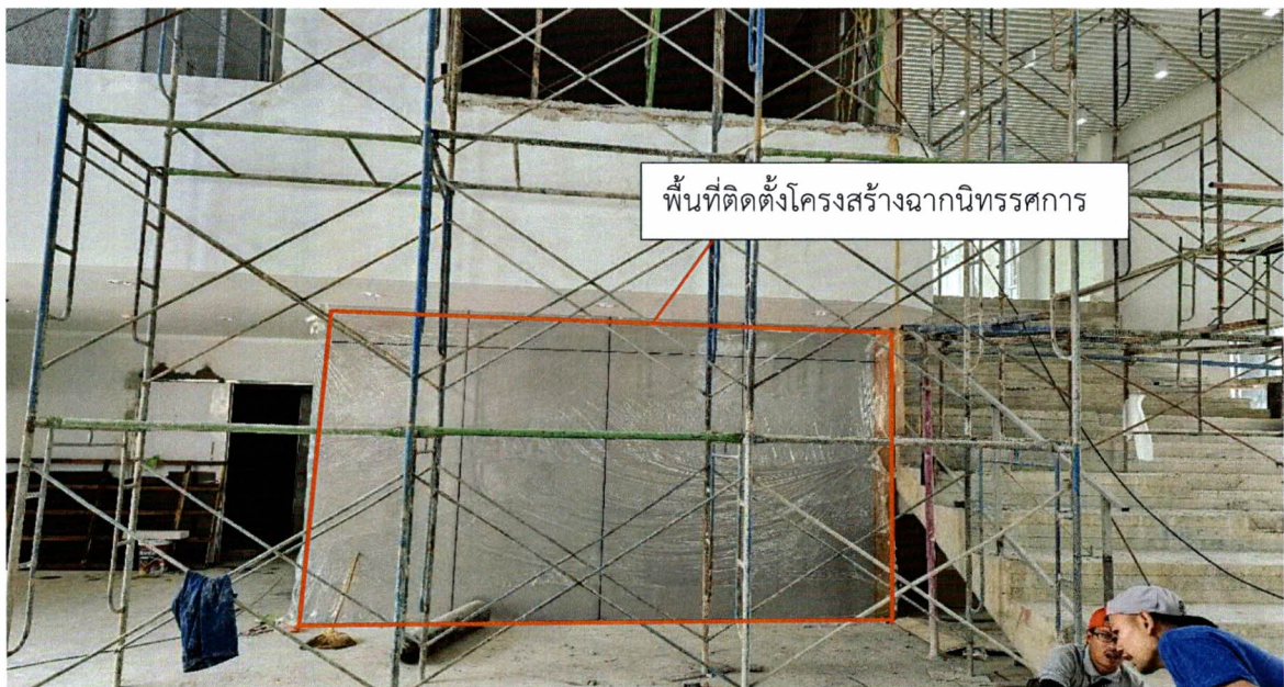
ภาพที่ 3 พื้นที่ติดตั้งโครงสร้างฉากนิทรรศการ
