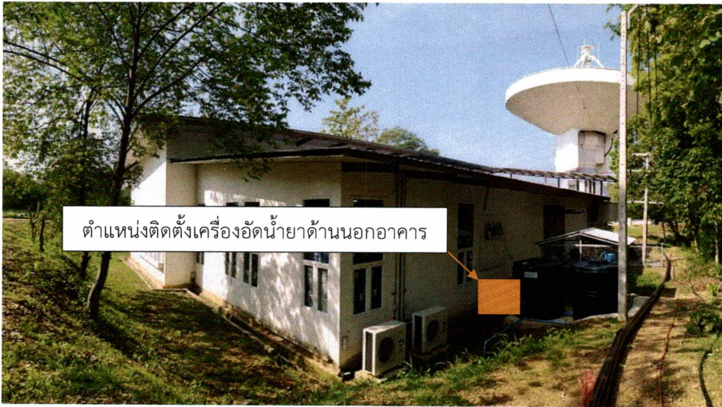
ตำแหน่งติดตั้งเครื่องอัดน้ำยาด้านนอกอาคาร
