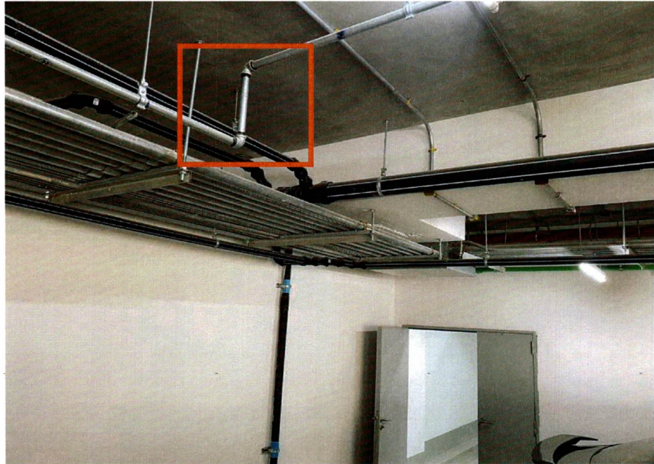
ภาพที่ 2 จุดเชื่อมต่อท่อลมที่สถาบันฯ ได้ติดตั้งไว้ก่อนหน้า
