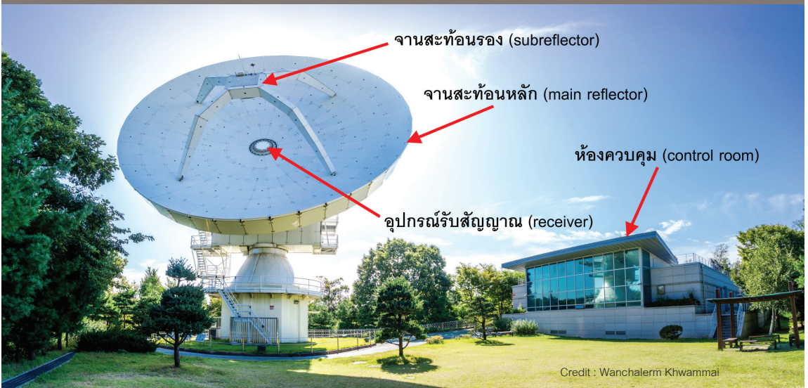
ภาพที่ 20 แสดงส่วนประกอบสำคัญของกล้องโทรทรรศน์วิทยุเควีเอ็น ย็อนเซ (KVN Yonsei) ที่ประเทศเกาหลีใต้
