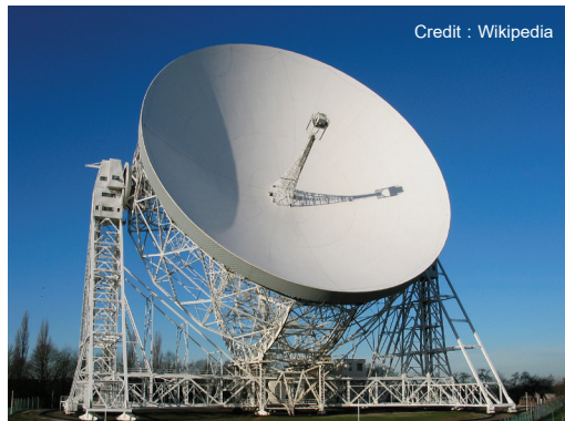
ภาพที่ 23 กล้องโทรทรรศน์วิทยุโลเวลล์ (Lovell) ขนาดเส้นผ่านศูนย์กลาง 76.2 เมตรที่สหราชอาณาจักร
