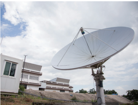
ภาพที่ 34 กล้องโทรทรรศน์วิทยุขนาดเส้นผ่านศูนย์กลาง 4.5 เมตร และห้องควบคุม (ตู้ทรงสี่เหลี่ยมด้านข้างกล้อง) ณ อุทยานดาราศาสตร์สิรินธร จังหวัดเชียงใหม่
